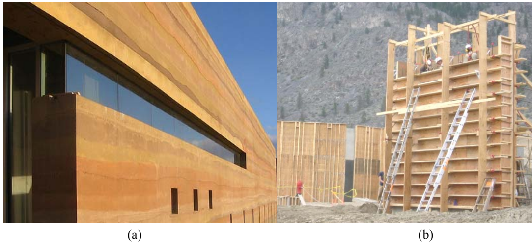
Figura 2.23 (JALALI e EIRES, 2008): Taipa: (a) Parede em taipa; (b) Aplicação de taipa.
