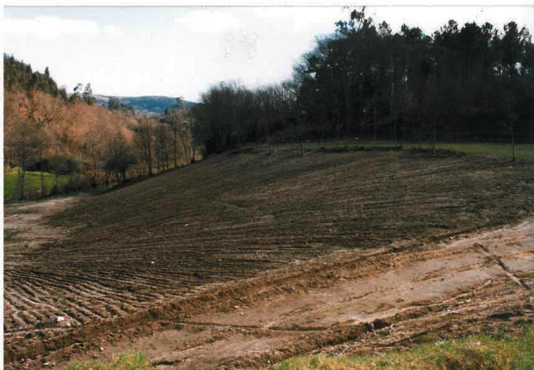
Figura 12- Terraplanagem do recinto, 1993
