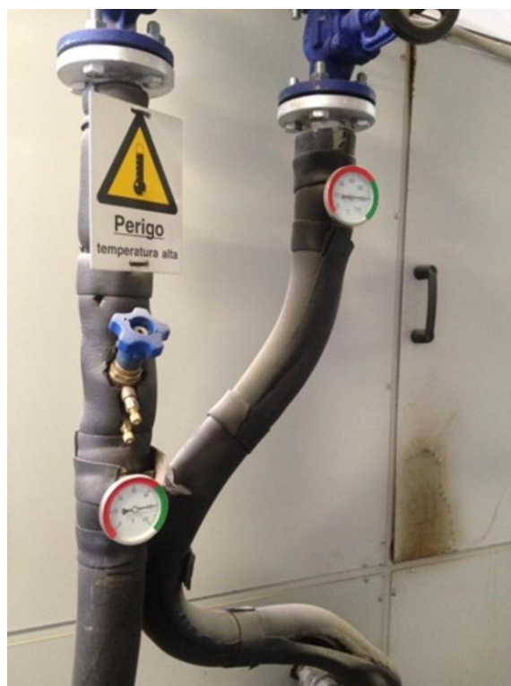
Figura 53 – Manómetros de Temperatura Wikoma
