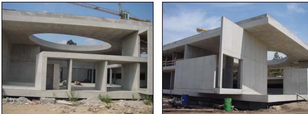
Figura - 10 – Fotografias ilustrativas da cobertura e do bloco 1.
