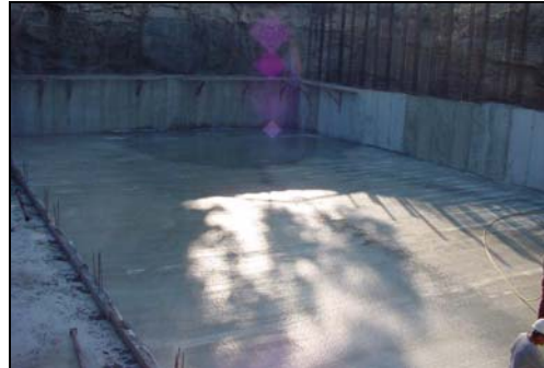
Figura 3 – Pavimento do polivalente em BRFA, sem juntas.
