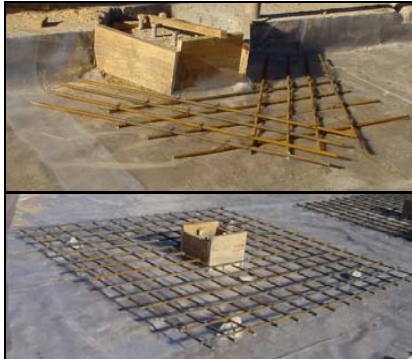
Figura 4 – Pormenores de reforço nos pavimentos de BRFA.
