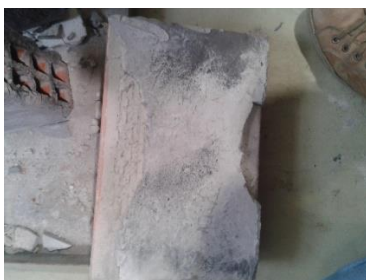
g) Argamassa de cal hidráulica + PCM + fibras
