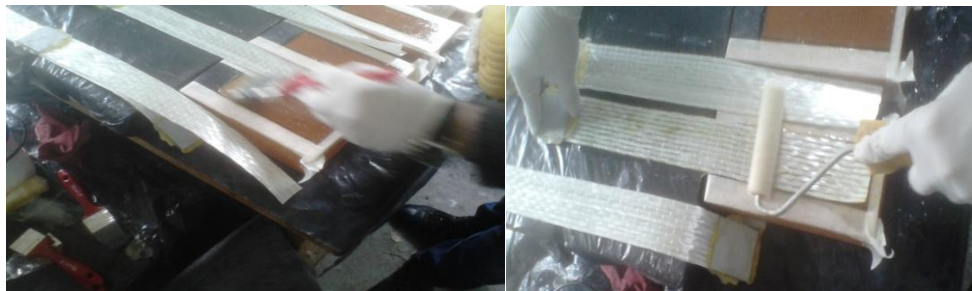
c) Aplicação do primário.
