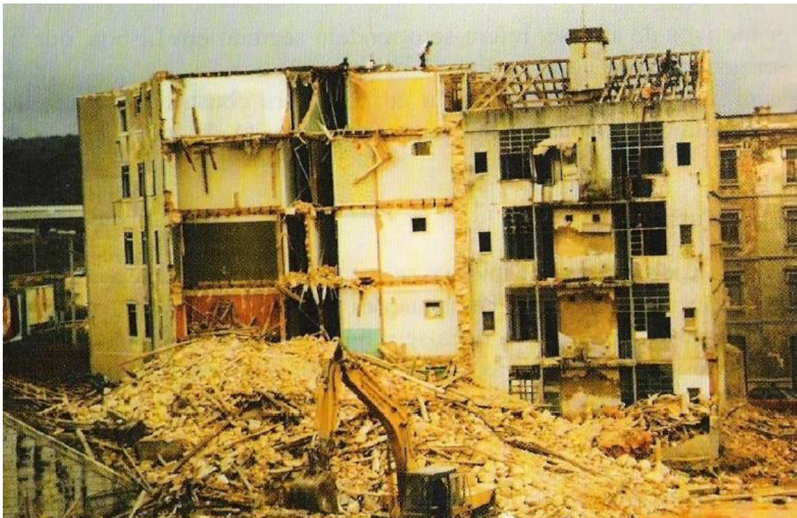
Figura 3.1 - Demolição tradicional (Fonte: Couto et al. , 2006)
