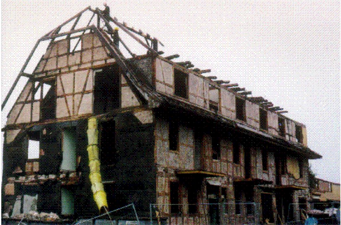
Figura 4.2 - Desconstrução do hotel em Dobel (Fonte: Schultmann, 2000)
