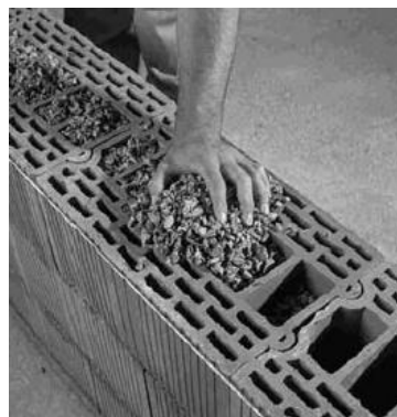
Figura 27- Preenchimento de blocos cerâmicos com cortiça granulada [18]
