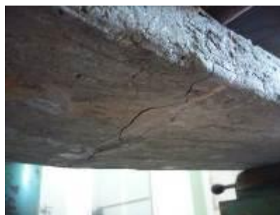
Figura 16: Fissura na placa com adição de fibra de PET submetida à carga no meio do vão
