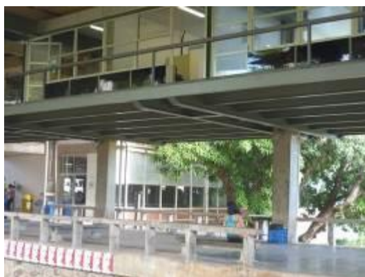
Figura 1: Mezanino da Faculdade de Arquitetura da UFBA
