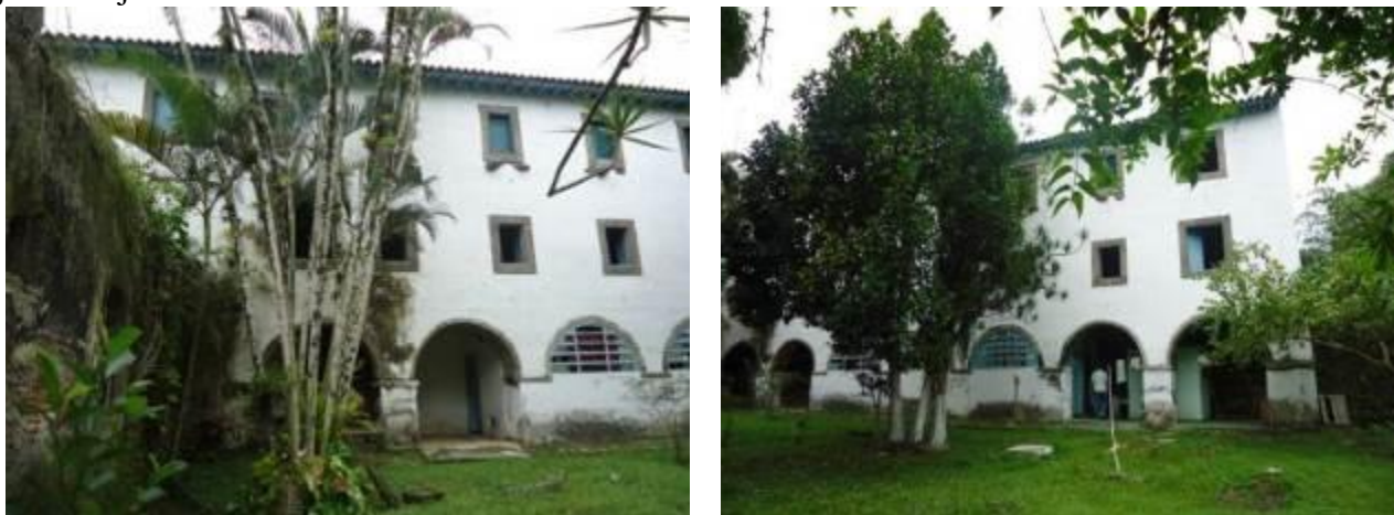
Figura 8 – Vista lateral do Convento com as Ruínas (esquerda) e as arcadas no piso inferior.
