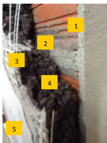
Figura 31: Pormenorização de um sistema ETICS com aglomerado de cortiça expandida
