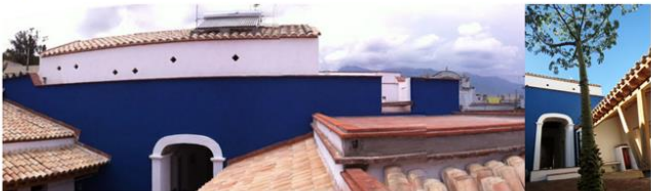
4. e 5. Interior Casa Allende, Vales Centrais _Oaxaca [autor]
