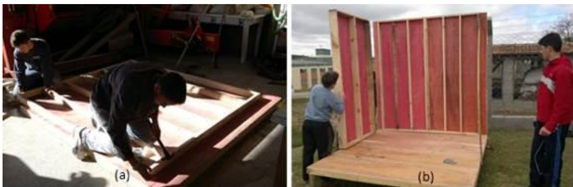
Figura 2. Construção dos protótipos: (a) execução das paredes e plataformas em galpão; e (b) montagem das paredes auto portantes sobre a plataforma no local.
