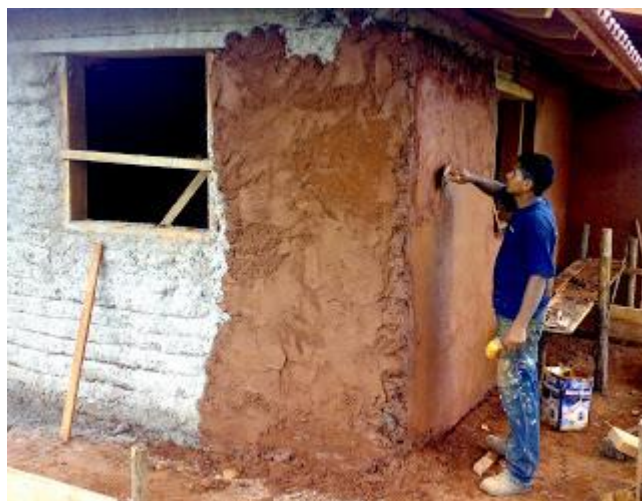
Fig.8 – Após o chapisco, vem o reboco à base de terra.
