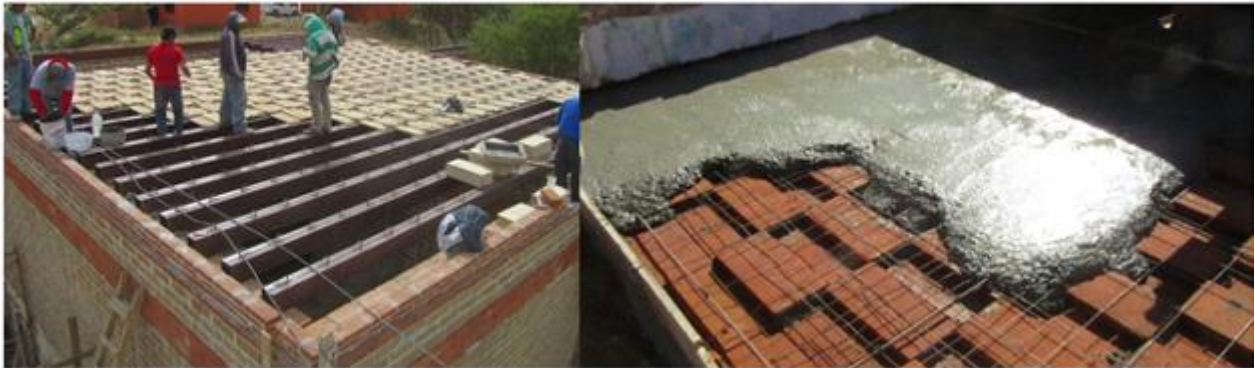
8. Primeira Capa _ vigas com tijolo de burro 9. Segunda Capa betão armado com malha electrosoldada
