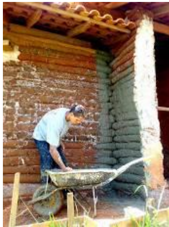
Fig.7 – Eliminados os sacos de polipropileno, faz-se um chapisco bem ralo..
