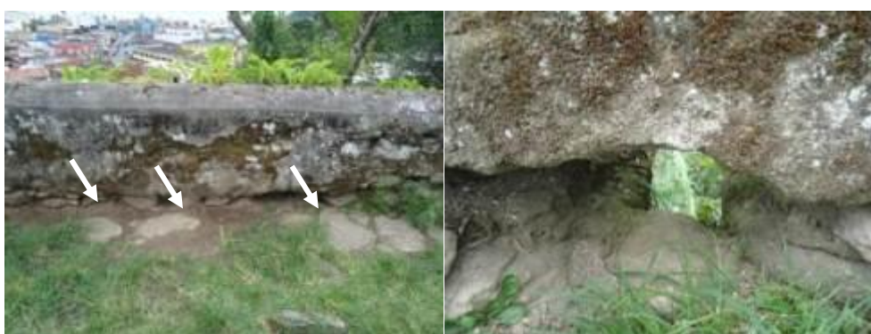
Figura 3 – Mureta lateral à esquerda do Adro, com aberturas na base.
