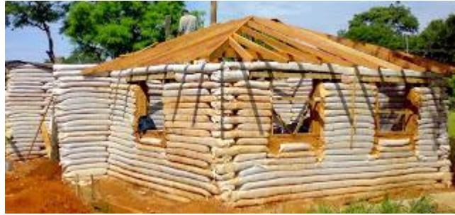
Fig.6 – Terra crua compactada em sacos de polipropileno, consolidadas com o peso do telhado.
