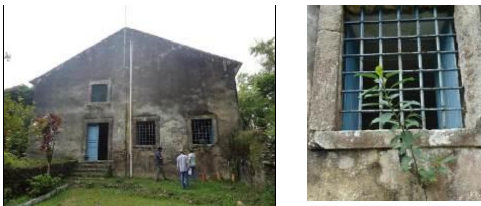
Figura 5 – Vista da parede dos fundos (esquerda) e detalhe da janela (direita) da Igreja e Convento.
