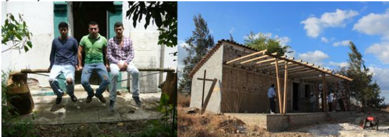
15. Prototipo de viga 16. Aplicação em obra, San Pedro Apostol [autor]
