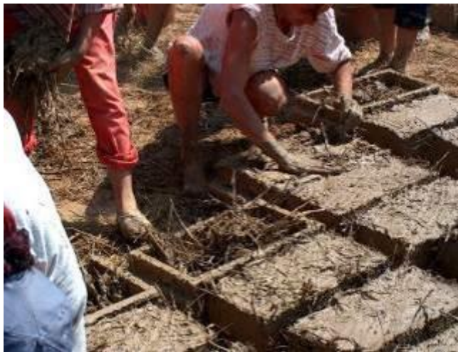
Figura 5 – Técnica dos tijolos de adobe.
