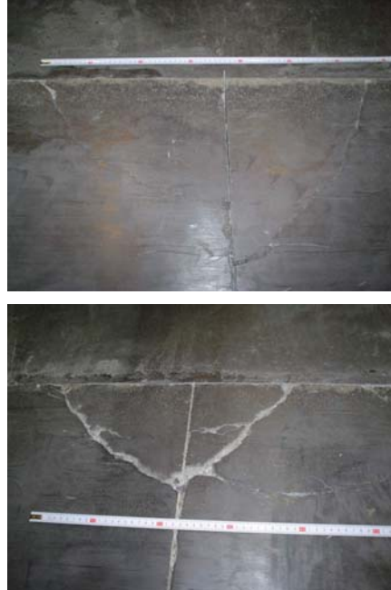
Figura 2 – Fendilhação observada
