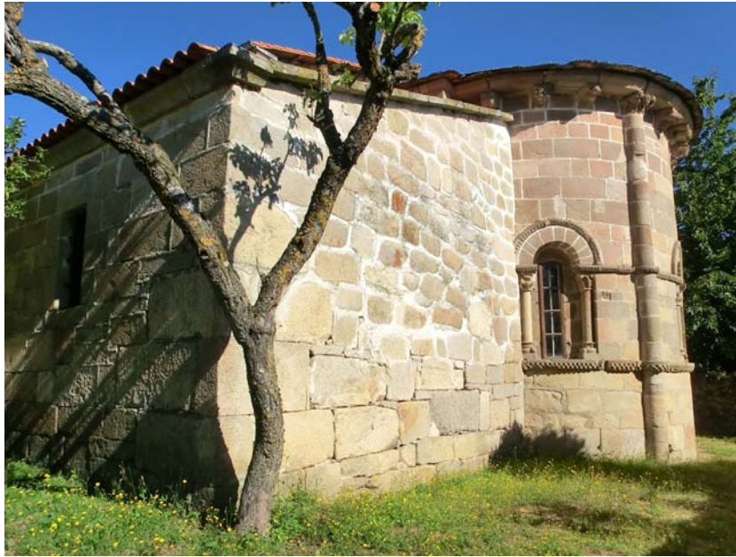
FOTOGRAFÍA 7: ÁBSIDE DE LA ANTIGUA IGLESIA MONÁSTICA DE SOBRADO DE TRIVES.
