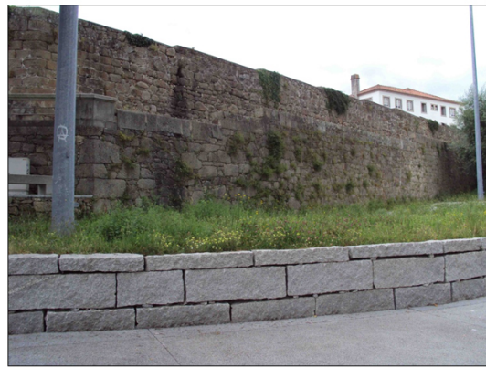
Possível remanescência da barbacã na Traversa do Pessegal.
