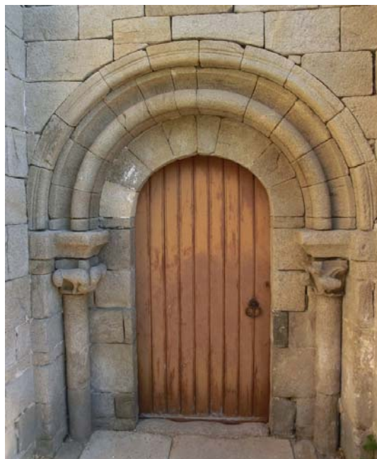
FOTOGRAFÍA 4: PUERTA DEL LADO SUR DE LA ANTIGUA IGLESIA MONÁSTICA DE SOBRADO DE TRIVES.
