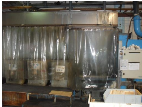
Figura 27 - Posto de decapagem a ácido
