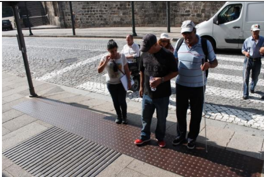
Imagem 5: Passadeira com piso tátil
