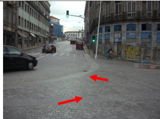
Imagem 6: Ausência de divisão entre espaço pedonal e passagem de veículos
