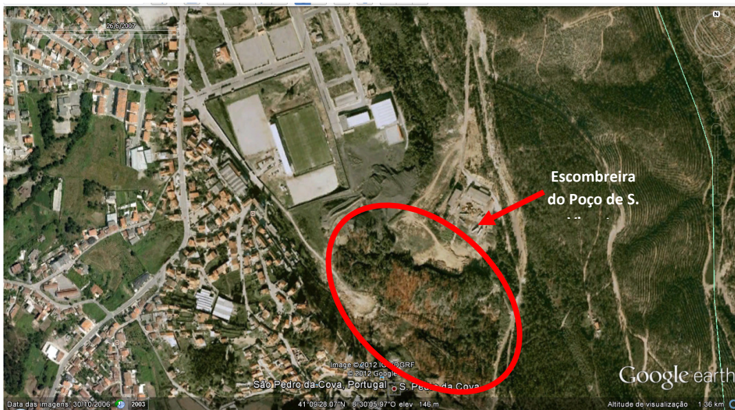
Fig. 12 – Imagem da escombreira do Poço de S. Vicente da mina de S. Pedro da Cova em 2007.
