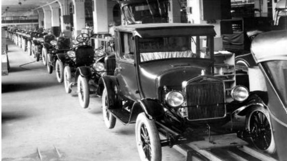
**Figura 2.2 - Linha de produção do Ford Model T, na sua típica cor negra, a única disponível após a implementação das linhas de montagem móveis em 1913, por permitir um tempo secagem inferior à das restantes cores.**
