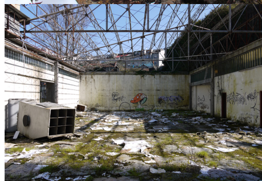
87 | 88 | Pavilhão onde serão colocados os quartos.
