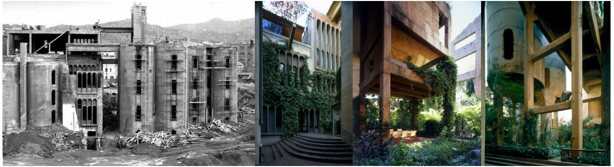
14| Fábrica de Cimento de Barcelona. Em construção. Autor desconhecido 15|16| 17| Fábrica de Cimento de Barcelona. Exterior. Autor: Ricardo Bofill
