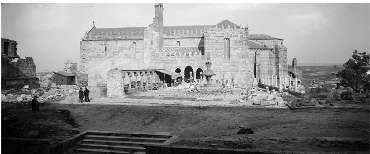
FIGURA 50. Fotografia aquando a intervenção da DGEMN. Fotografia retirada do sítio: www.monumentos.pt - igreja de Santa Clara
