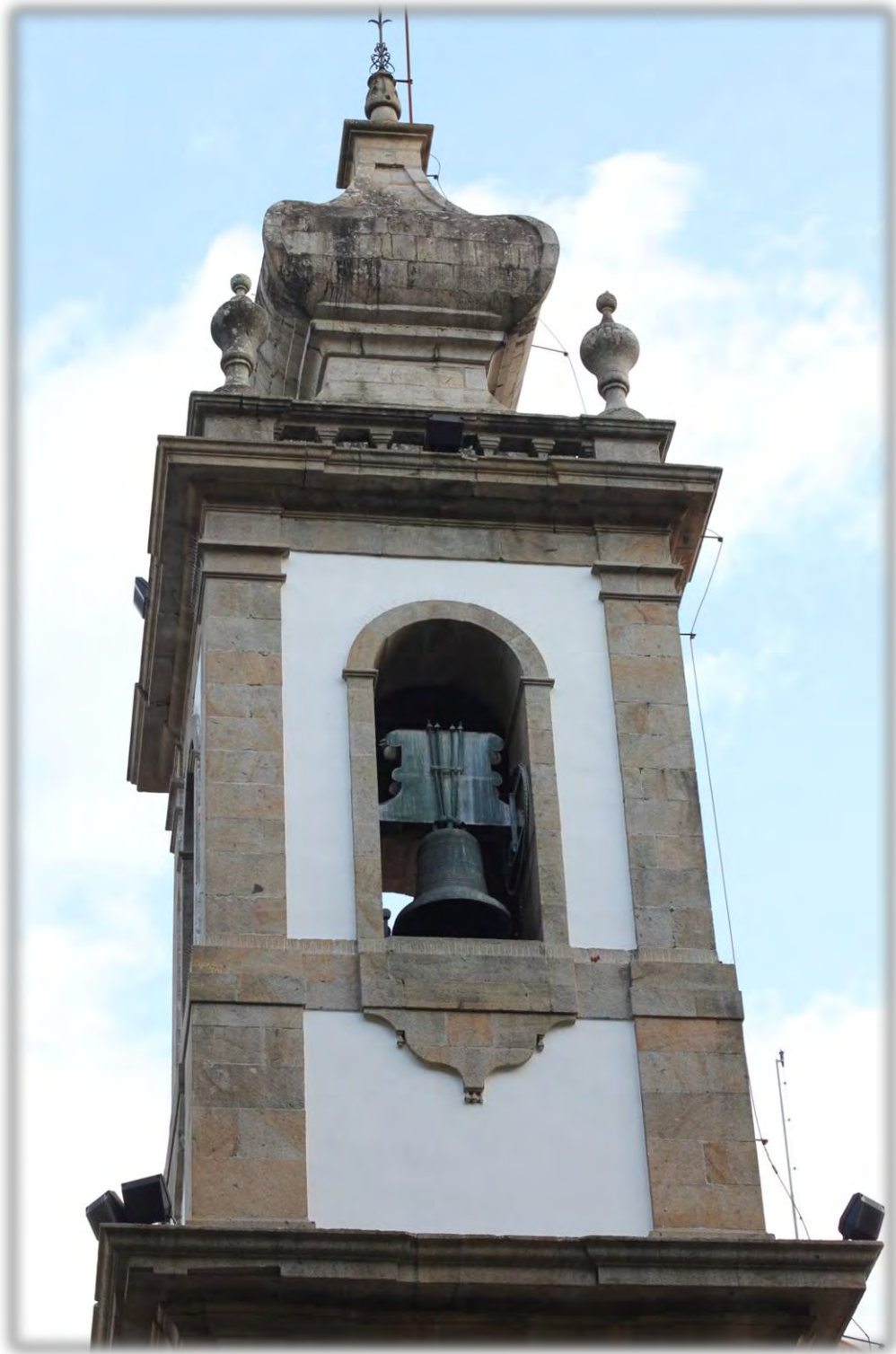
Figura1: Torreão da igreja dos Terceiros de São Francisco de Ponte de Lima.
