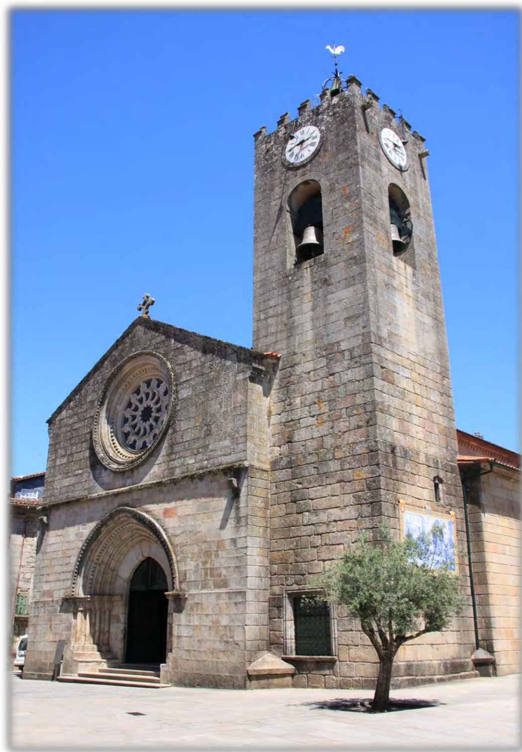
Figura 1: Igreja Matriz de Ponte de Lima.
