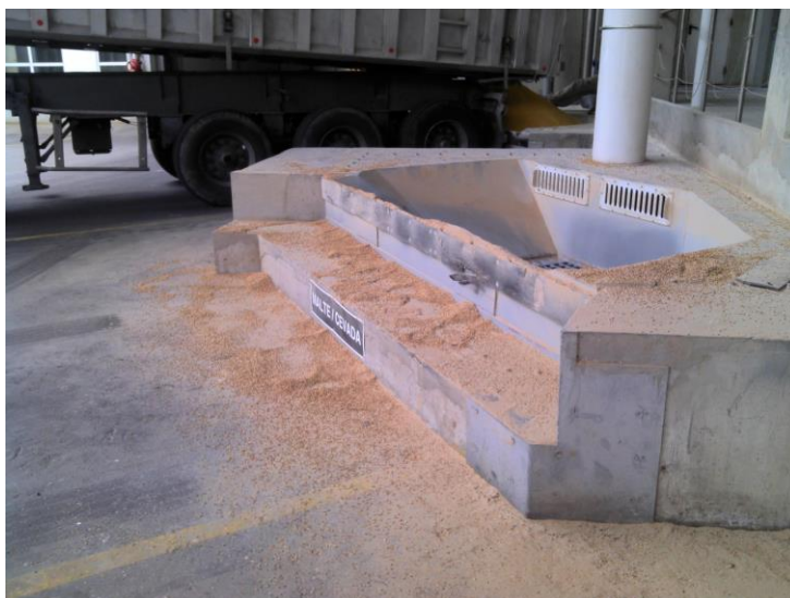
Figura 28- Tegão de Descarga de Malte.
