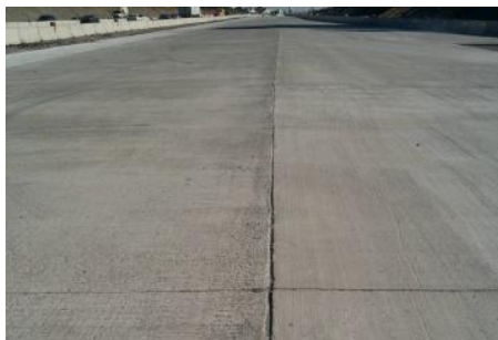
Figura 2.12 – Combinação de textura com rasgos transversais à esquerda e acabamento em tapete à direita (Adaptado de Anderson et al. (2012))
