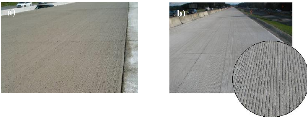
Figura 2.11 – Tipos de textura em pavimentos rígidos: a) Textura em tapete; b) Textura com rasgos longitudinais (Adaptado de Anderson et al. (2012))
