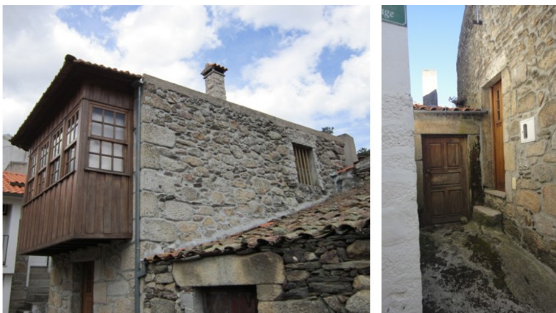
Figura 28 – (esquerda) Fachada contígua ao edifício devoluto; (direita) Beco de acesso à porta das traseiras
