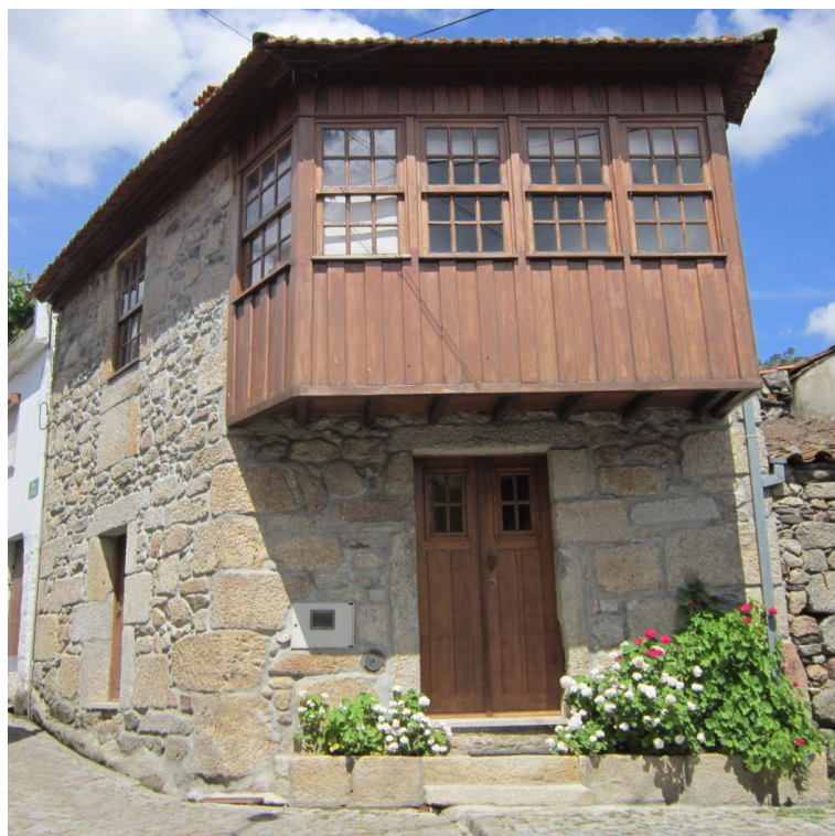
Figura 27 – Edifício vernáculo em estudo
