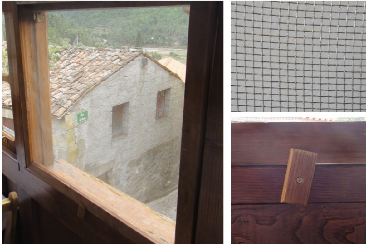
Figura 34 – (esquerda) Sistema de proteção desmontável; (direita) Rede e sistema de patilha
