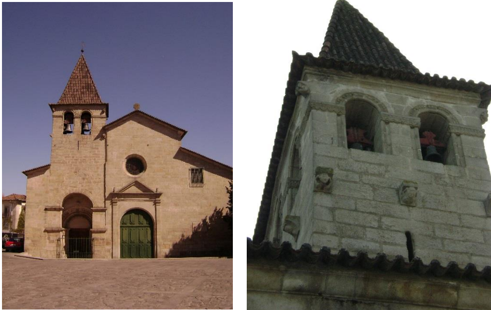
Figura 3 – Fachada atual e torre sineira da igreja Matriz de Chaves (foto do autor).
