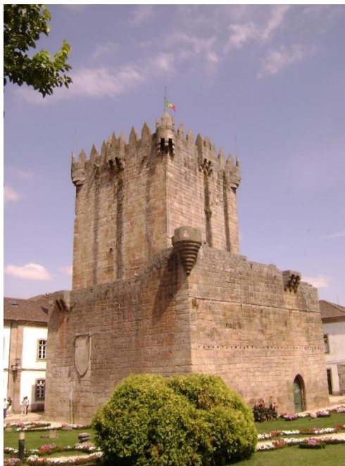
Figura 6 – Torre de menagem; balcões sobre matacões e troneiras (foto do autor).
