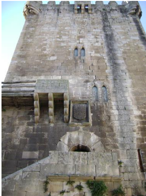
Figura 5 – Porta de entrada da torre de menagem; escadaria em “L”; seteiras de arco quebrado e balcões sobre matacões (foto do autor).
