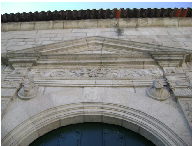
Figura 9 – Portal lateral norte da igreja Matriz (foto do autor).
