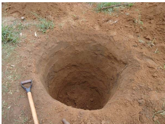
Figura 6 – Escavação do poço 2
