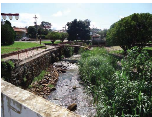
Fig.3 Ponte na Praça Japonesa Paulista sobre o Ribeirão Lajeado em Avaré
