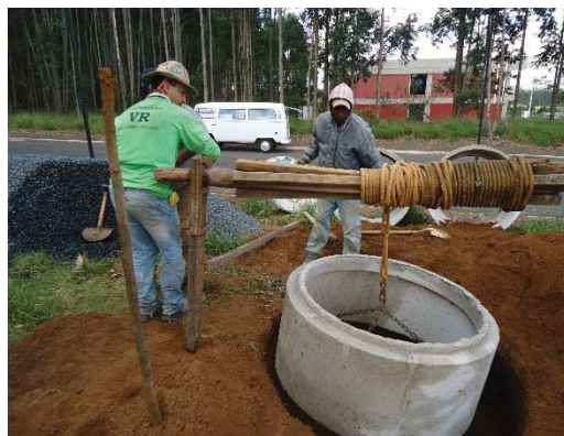
Figura 7- Descida dos anéis poço 2
