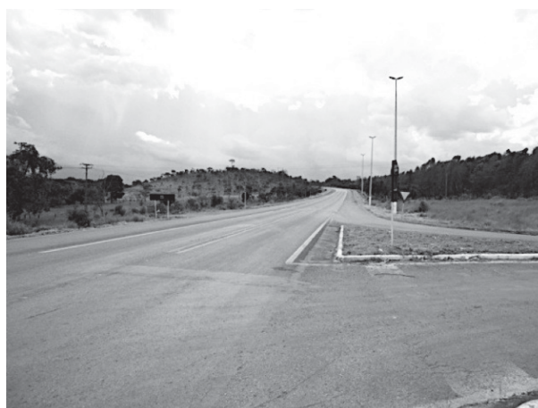
Fig. 6 Vista da BR 251 a partir da interseção com a DF 473
