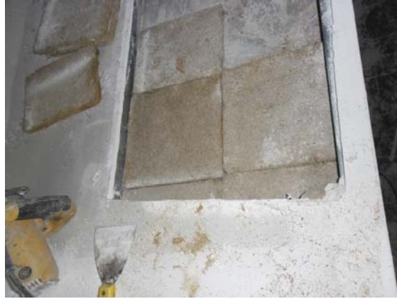
Figura 6 - Montagem do painel.
