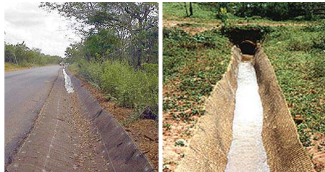
Fig. 4 e 5 Bacias de infiltração e estocagem com sistemas de mantas de drenagem substituindo o sistema convencional meio fio – sarjeta – boca de lobo Fonte: UFSC (2012)
