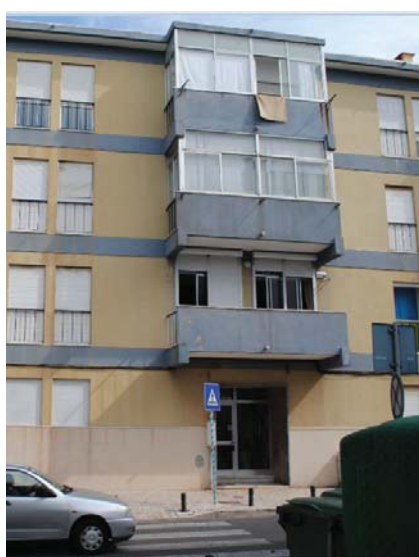
□□ varanda projetada sobre a via pública (década de 1970)
