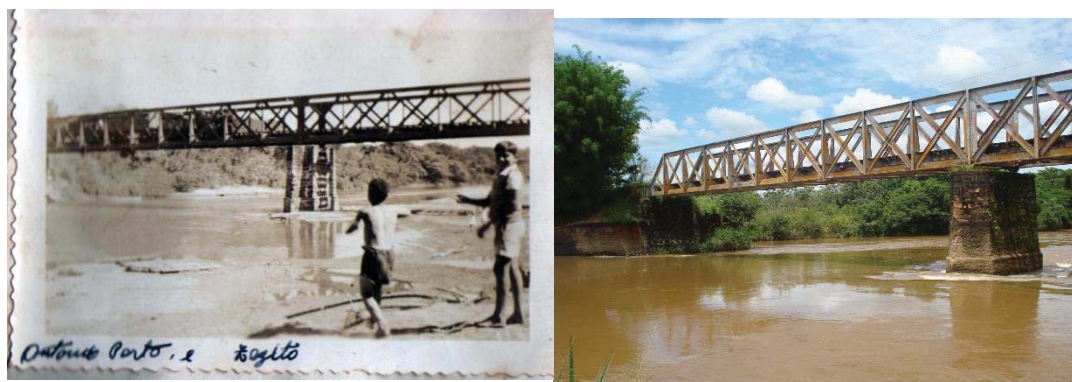
Figura 1: Ponte sobre o Rio Pardo. Estrada de Ferro São Paulo e Minas. Fonte: Núcleo do Centro Histórico de Altinópolis. À direita, imagem da ponte atualmente.
