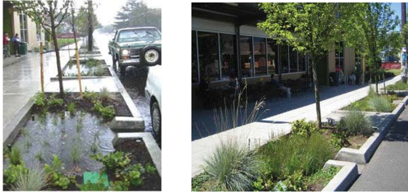
Fig. 3 Jardins de infiltração em passeios públicos Fonte: UFSC (2012)
