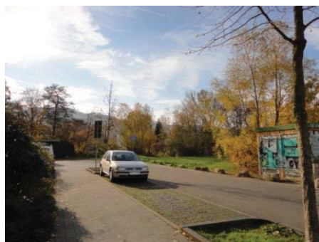
Fig. 5 e Fig. 6 Canal de infiltração e uso de pavimentação permeável. Arquivo pessoal
