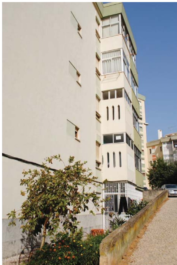
Fig.12 Concelho de Oeiras, edifício descaracterizado da década de 1960, imagem atual
