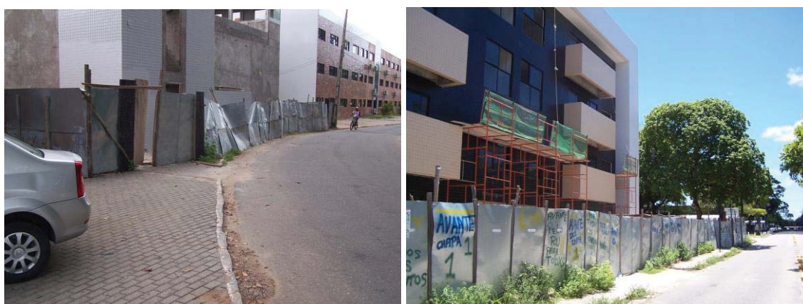
Fig. 5 e 6 Obras impossibilitando a circulação do pedestre na calçada
