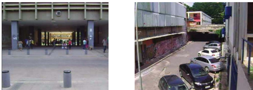
Figura 6 e 7-Passagem sob o edifício e ponte sobre via de serviço.
