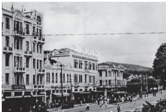
Fig. 2 Edifício Ciampi (primeiro à esquerda) em 1940. Fonte: Maria do Resguardo, 2014.
