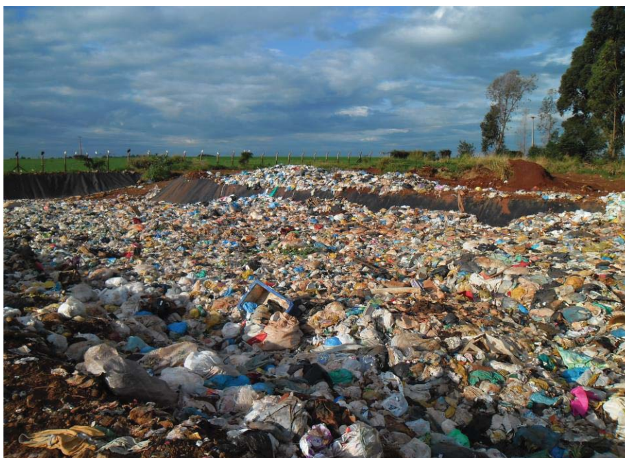
Fig. 8: Resíduos sólidos disposto na vala do aterro sem cobertura
