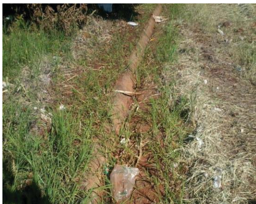
Fig. 6 Canaleta para drenagem de água pluvial
