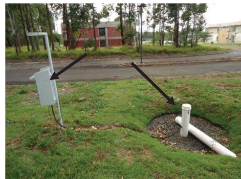
Figura 13- Monitoramento e datalogger poço 2
