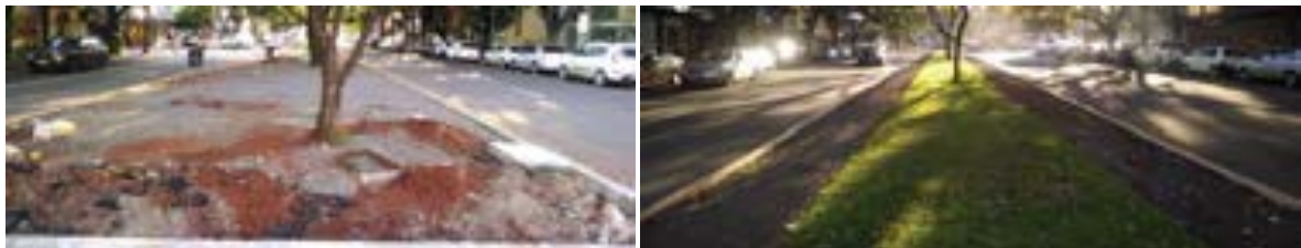
Figura 3. Registros fotográficos atuais do local
