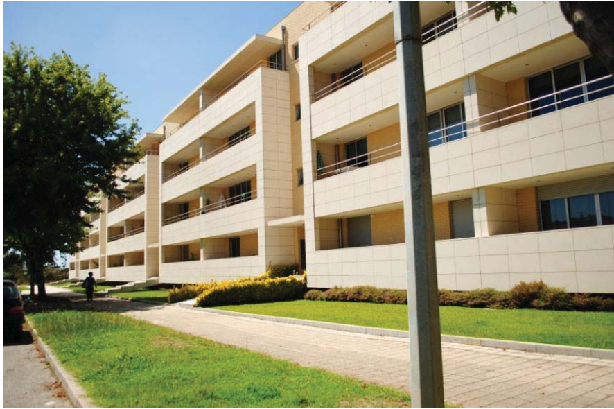
Fig. 11 Concelho de Matosinhos, logradouro na frente do lote, década de 2000
