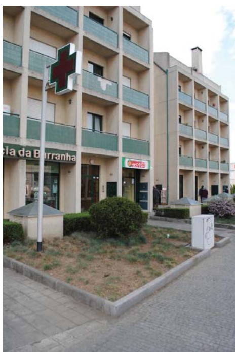
Fig.10 Concelho de Matosinhos, logradouro na frente do lote (década de 1990)
