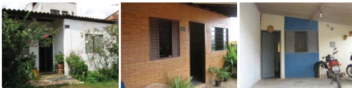
Figura 2 Exemplos de casas analisadas: a) autoconstrução; b) mutirão; e c) conjunto habitacional. Fonte: Arquivo pessoal, 2009.
