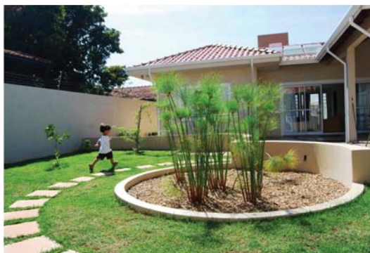
Fig. 6 Sistema unifamiliar de tratamentos de esgoto, tipo zonas de raízes. Fonte: UFSC (2012)
