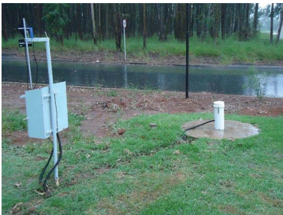
Figura 10 - Poço 1 em funcionamento
