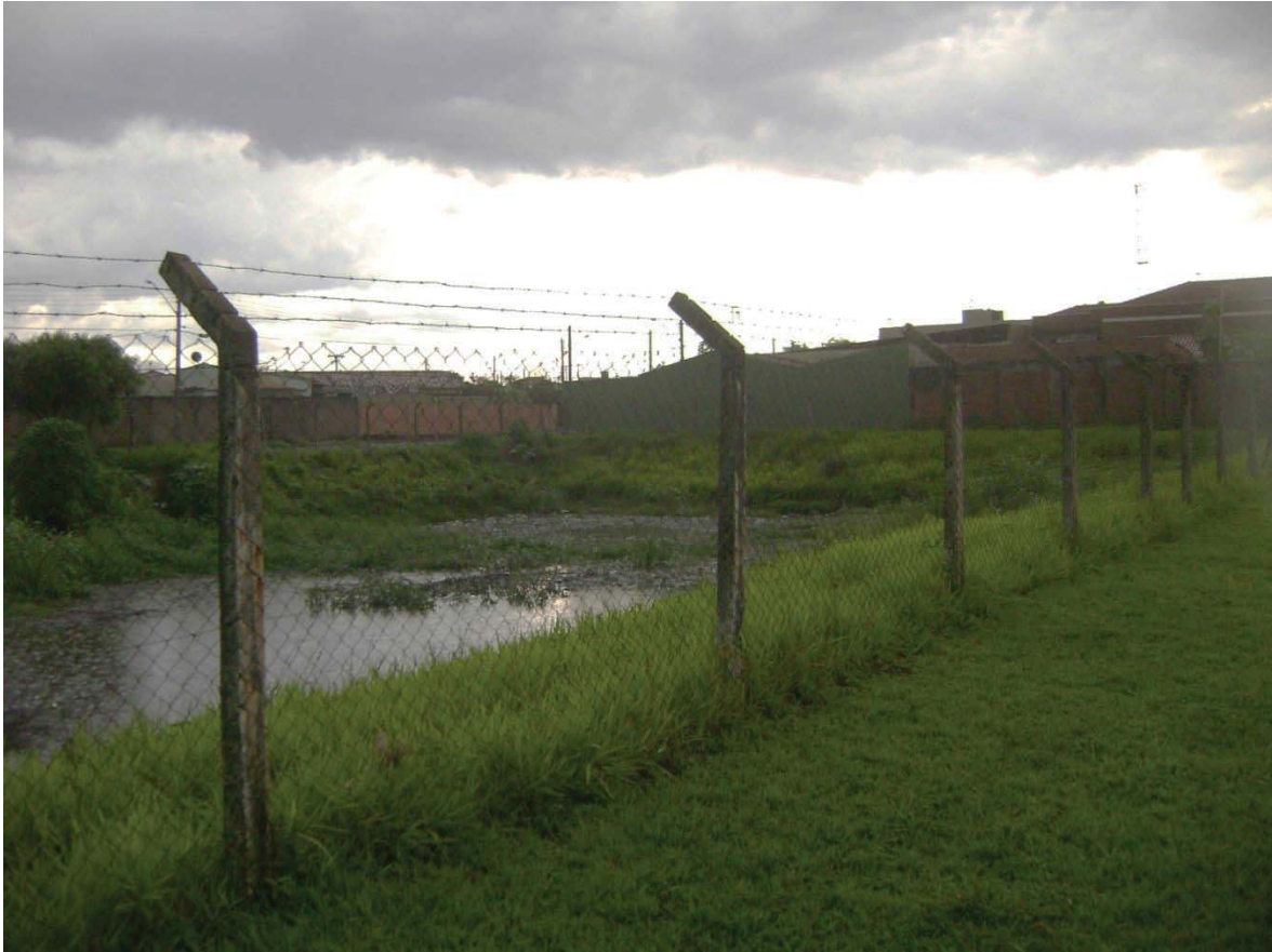
Fig. 4 Bacia de infiltração durante precipitação. Fonte: Autor (2013).
