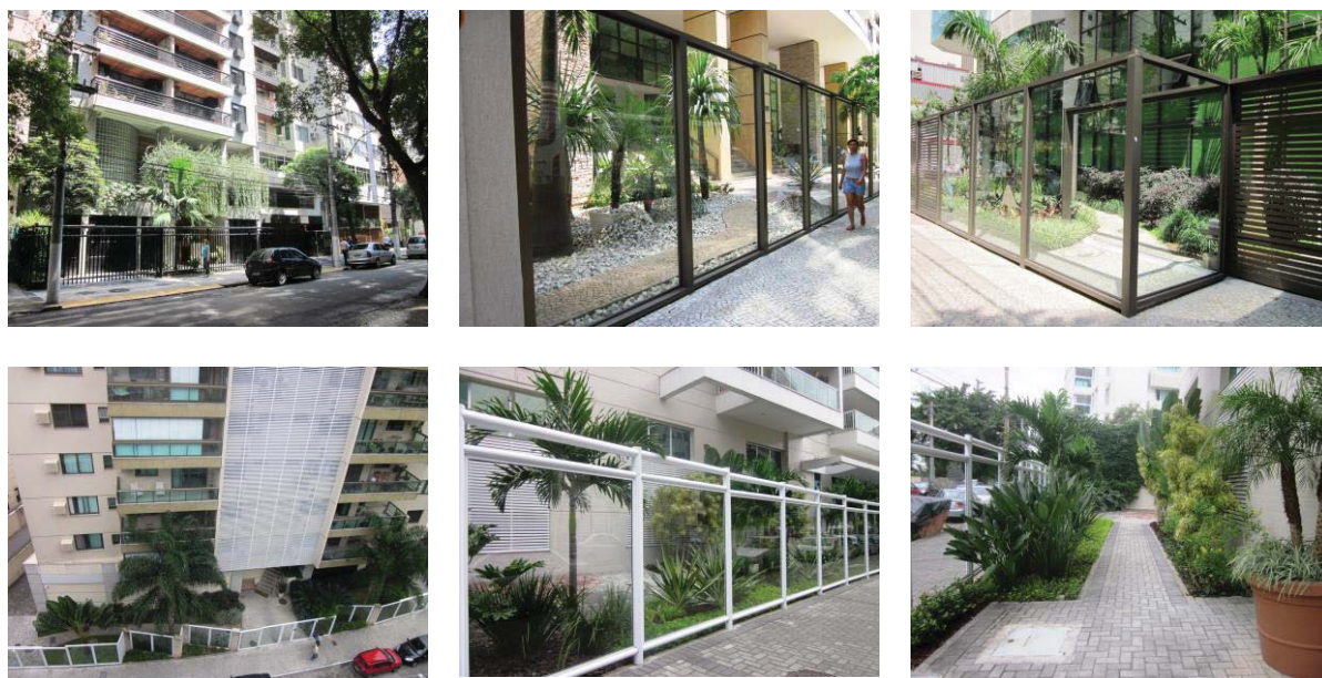
Fig. 3: Exemplos de utilização do vidro como barreira física entre o espaço público e o espaço privado
