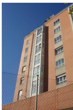
Fig. 1 El mirador tradicional de la foto de la derecha está ahora transformado en un elemento de cristal que no tiene el muro de cerramiento por detrás y que modifica negativamente el flujo de calor en determinadas fachadas madrileñas. El Plan General de 1985 incentivaba estos miradores ya que no computaban como edificabilidad. Fuente: Archivo del autor.
