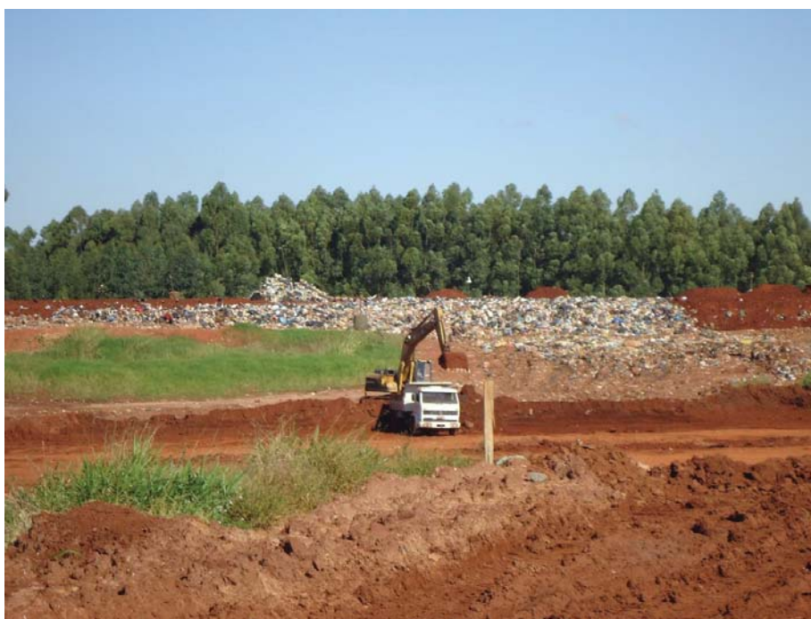
Figura 2 – Vista do Aterro Sanitário Municipal de Campo Mourão.
