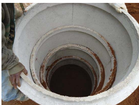
Figura 4- Instalação dos anéis poço 1
