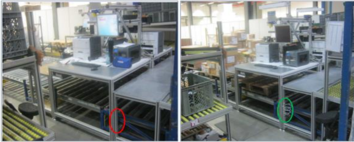
Figura 136 - Implementação de suportes no PT4
