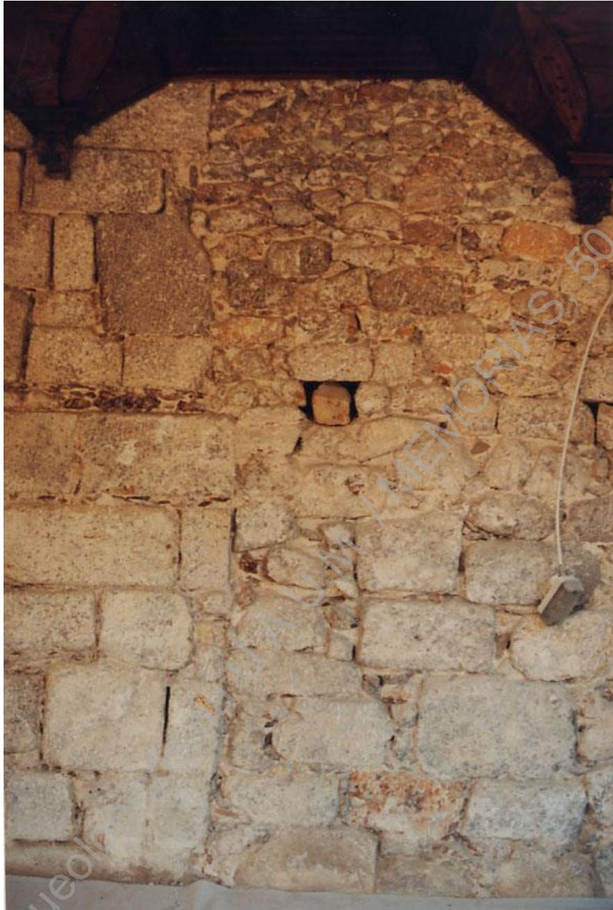
foto 35: Claustro do Cemitério. Pormenor do alçado interior Norte, evidenciando diversas fases construtivas.
