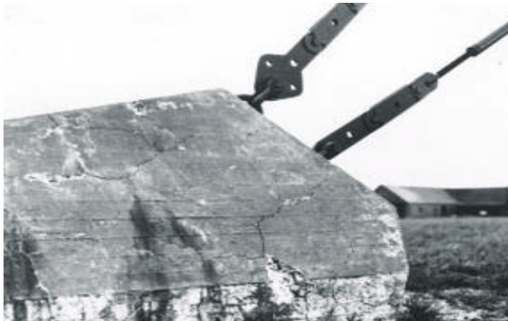
Figura 3.10 - Maciço de ancoragem [3.77].
