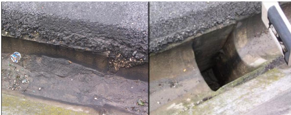
Figura 5.7: Fotos do sistema de meias canas do sistema de drenagem da plataforma da estrada da secção estudada.
