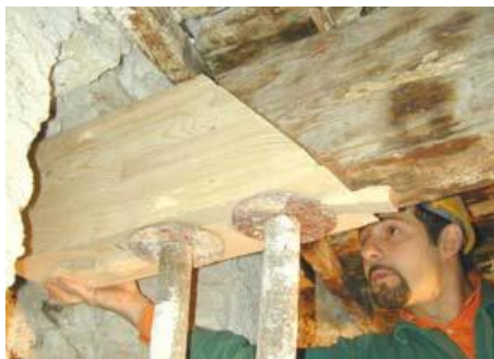
Figura 2.16 - Reforço estrutural pelo método tradicional (Piazza & Senno, 2001)
