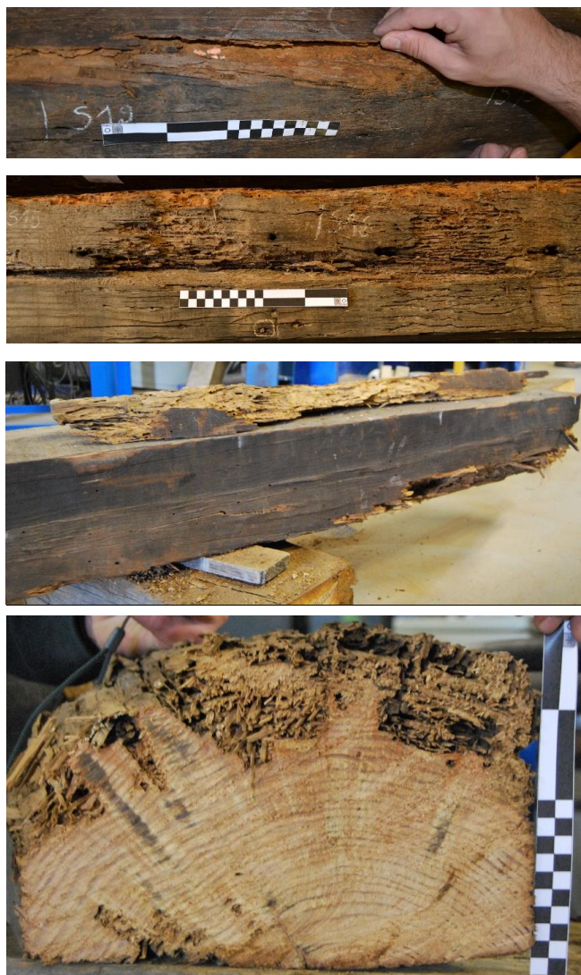
Figura 4.17 – Exemplos do efeito da presença de Hylotrupes bajulus nos elementos da Asna 1
