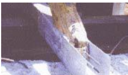
Figura 2.18 - Reconstituição da ligação, pelo método adesivo, através de varões compósitos e injeções com resina epoxídica (Appleton, 2003)
