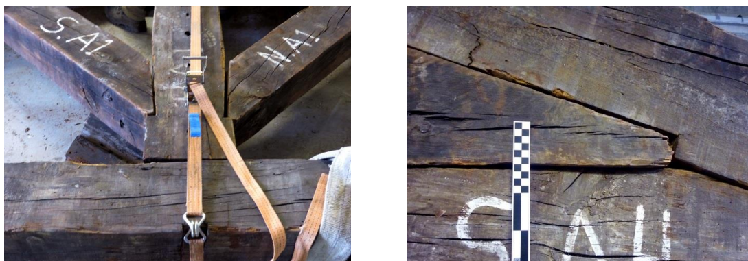
Figura 5.3 – Exemplos de ligações por entalhes
