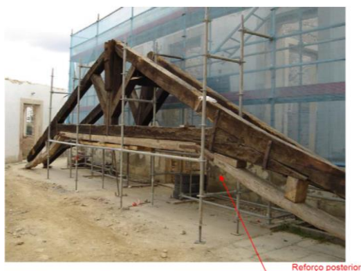
Figura 1.1 - Asna sobre o nível do solo no estaleiro da obra
