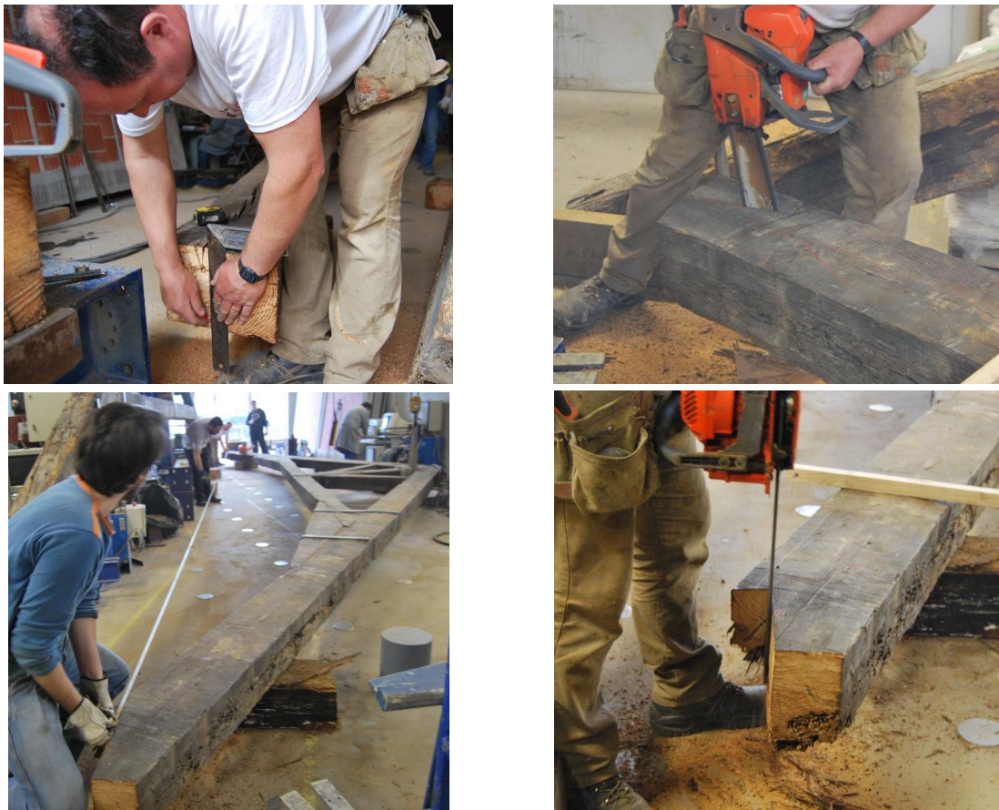
Figura 5.8 – Processo de intervenção dos apoios executada pelo carpinteiro
