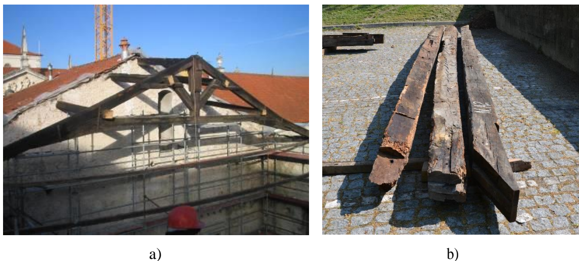
Figura 5.1 - Asnas: a) no local da construção; b) elementos desmontados nos laboratórios da Universidade do Minho
