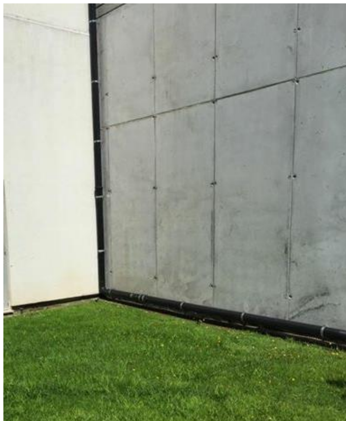
Figura 28 - Tubo de queda do sistema
