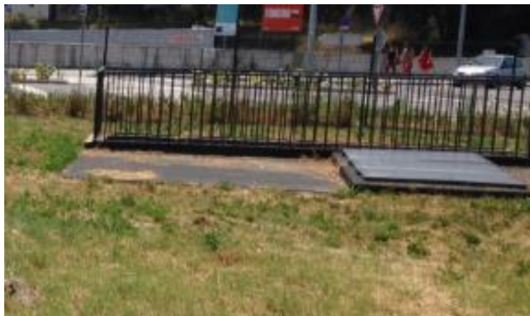
Figura 31 – Local onde se encontra o reservatório enterrado
