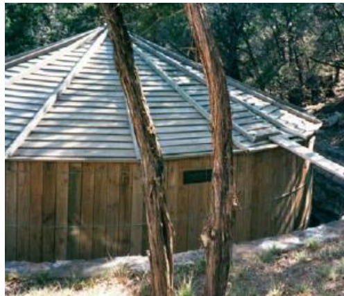
Figura 12 - Reservatório em madeira (Texas Water Development Board , 2005)
