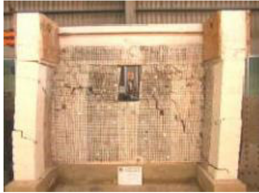
Figura 30: Ensaio do muro com reforço exterior de geomalha (Blondet et al., 2004).
