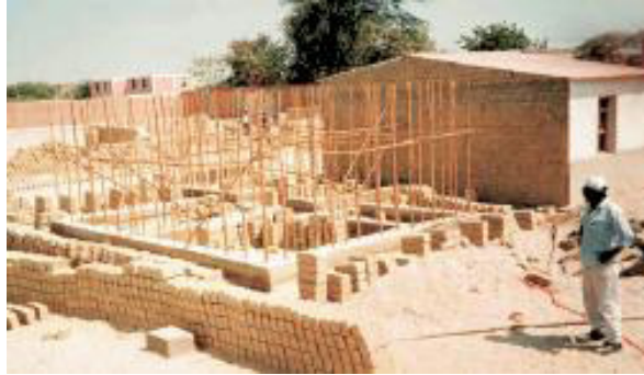
Figura 21: Colocação de elementos verticais(8).
