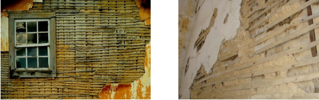
Figura 11: Construção em tabique (3).
