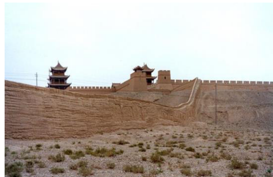
Figura 2: Troço da Grande Muralha da China construída em Taipa (2).
