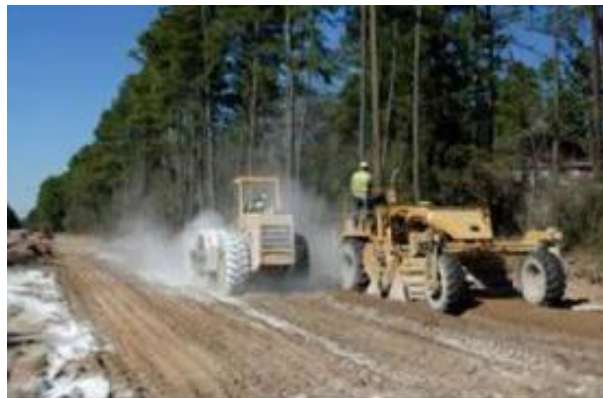
Figura 2. 16: Aplicação de cal no tratamento de solo de uma estrada.
