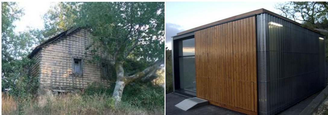
Figura 2. 15: Construções em tabique: a) habitação antiga; b) habitação moderna.
