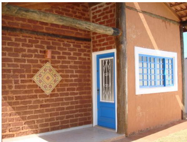
Figura 2. 12: Habitação construída com alvenaria de adobe.
