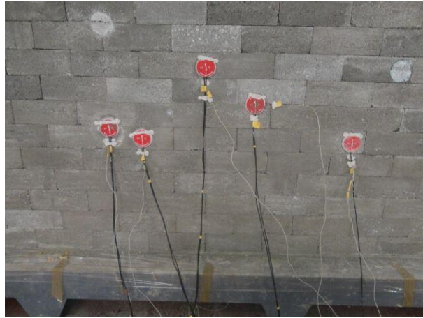
Figura 5. 2: Equipamentos instalados na parede de teste 1.
