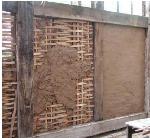
Figura 2. 14: Parede de terra sobre engradado em madeira
