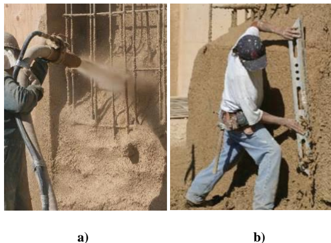
Figura 2. 7: Técnica monolítica de terra projetada: a) Projeção da terra; b) Regularização da superfície.
