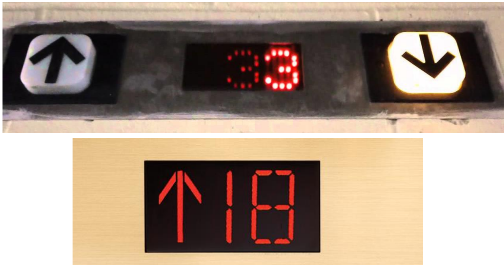
Figura 7 – Exemplos reais da indicação do sentido que o elevador irá tomar
