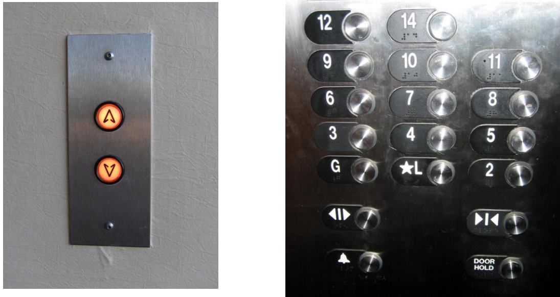
Figura 6 – Exemplos reais de uma botoneira dupla e de um painel de seleção do destino no interior de uma cabina
