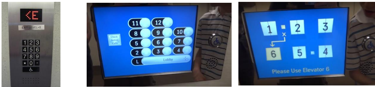
Figura 8 – Exemplos reais de sistemas de introdução do destino
