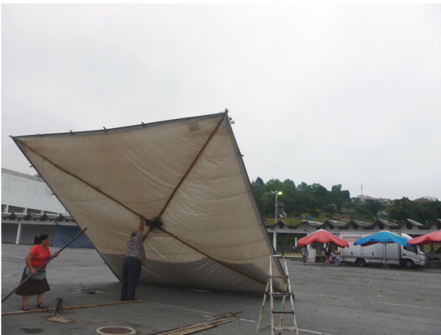
Fig. 36. Processo de montagem de uma cobertura a partir de varas de madeira. Foto de autor
