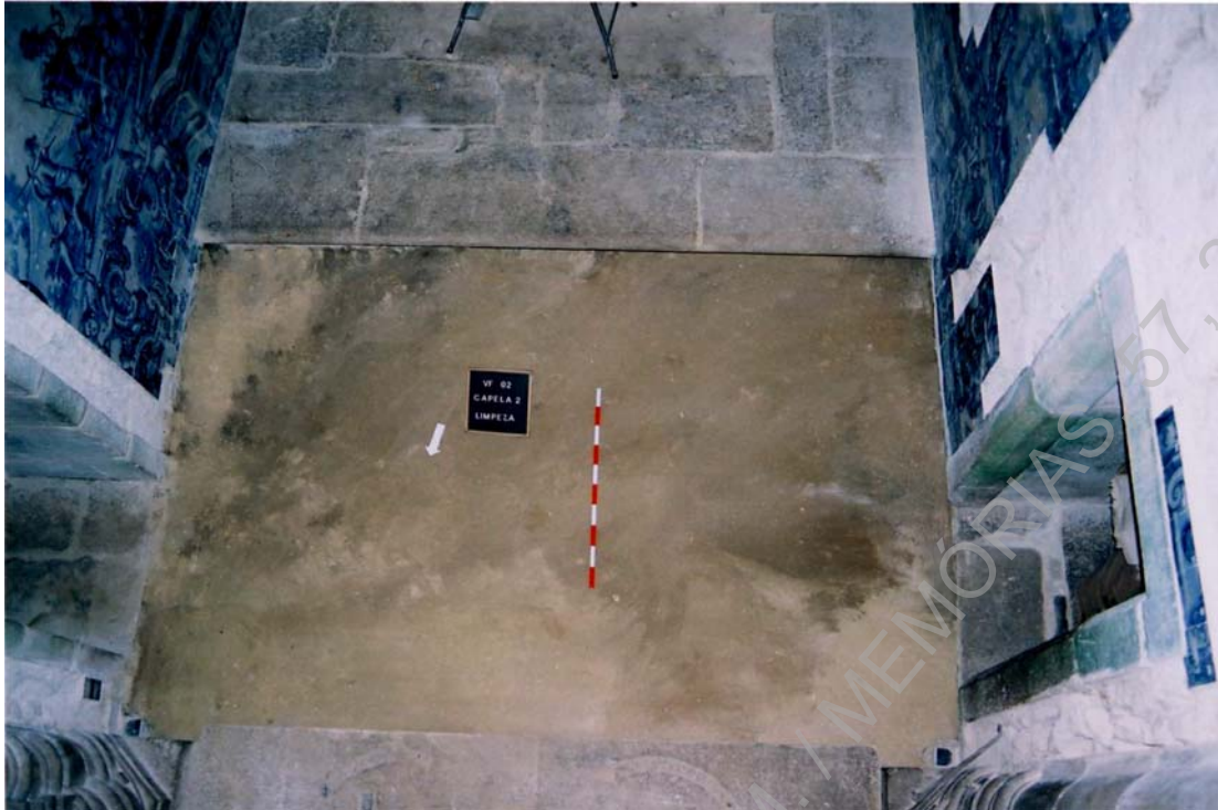
21- Sondagem 43 – Após levantamento lajeado (Ref. Neg. 27/27)
