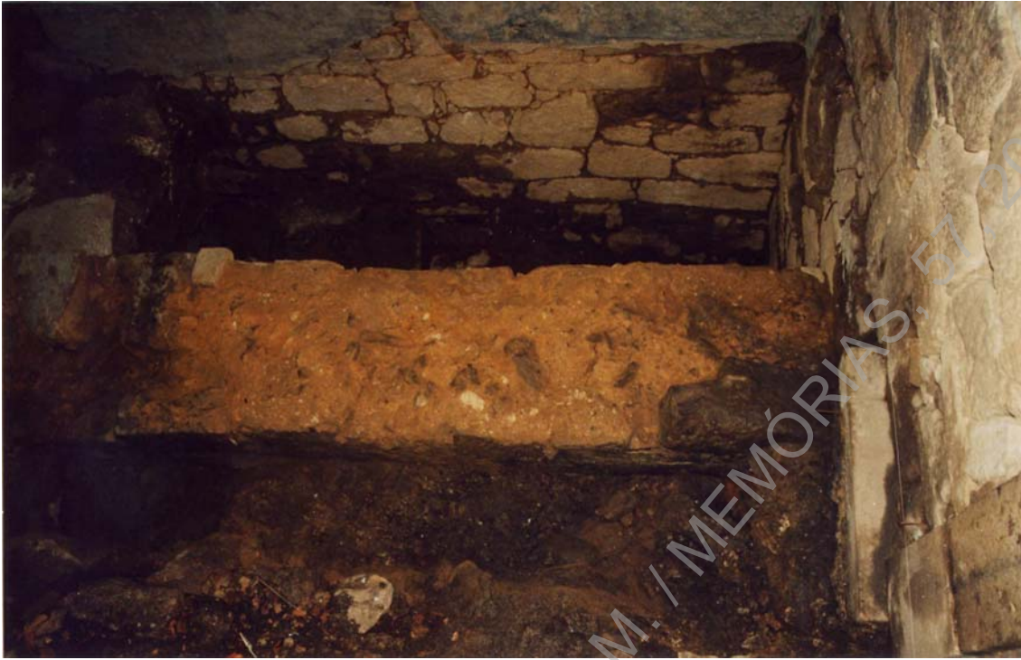
5- Sondagem 34 - U.E. [54] – Pormenor da estrutura (Ref. Neg. 5/5)
