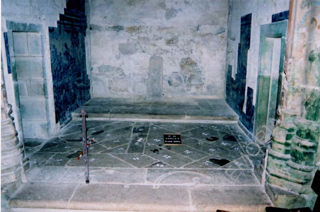
19- Sondagem 43 – Perspectiva geral do lajeado (Ref. Neg. 27/32)
