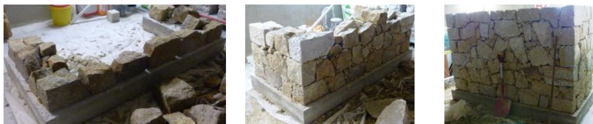
Fig. 3 – Fases de construção e aspeto final da parede de alvenaria de pedra
