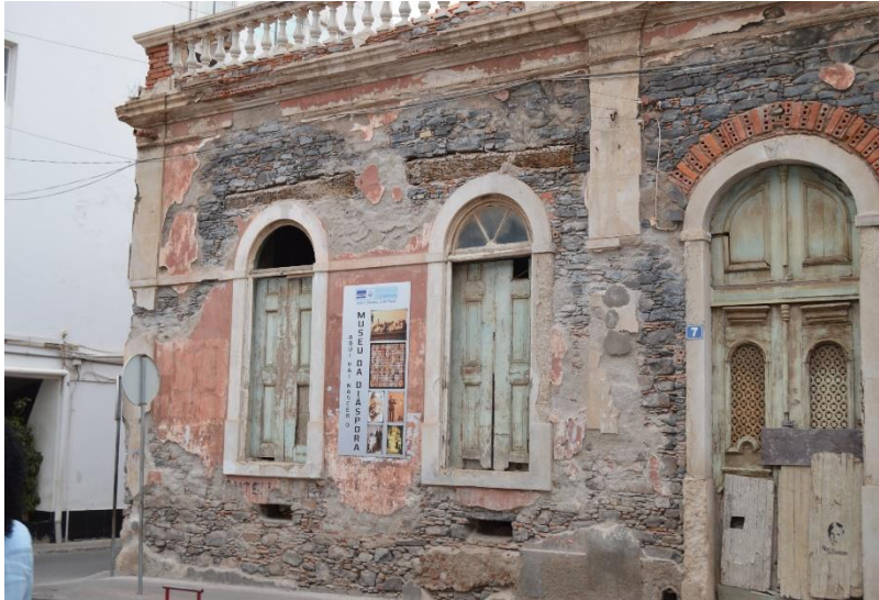
Figura 16 – Edifício em Plateau (Edifício que irá ser o novo museu da diáspora)
