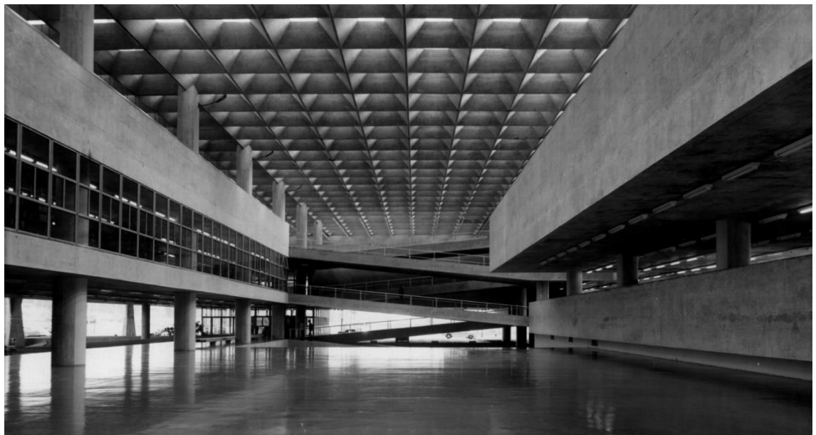
Figura 47 - Átrio central da Faculdade de arquitetura e urbanismo de São Paulo (Vilanova Artigas, 1961). Fonte:
