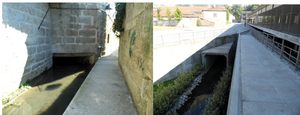
Fotografias 9 e 10. Ribeira de Couros canalizado na passagem pela malha urbana de Guimarães.
