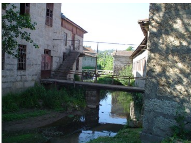
Fotografia 8. Vista parcial da fábrica de cortumes de Caneiros, ponte e dique (ao fundo).
