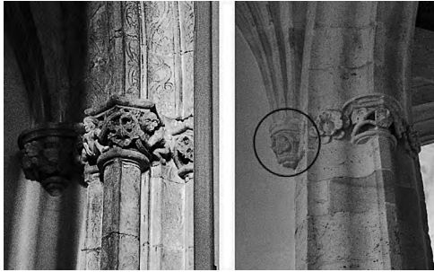
Figs. 6 e 7 - Pormenor da decoração de estilo manuelino no capitel do arco de uma das capelas laterais do corpo da igreja (esquerda). Pormenor de uma mísula de uma das capelas laterais aparentemente sobreposta pela parede lateral da capela (direita).
