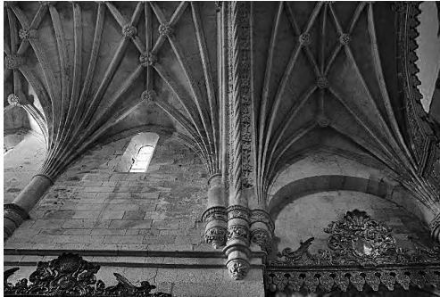
Figs. 4 e 5 - Perspectiva das abóbadas do cruzeiro e do corpo onde é visível o perfil mais rebaixado da abóbada do cruzeiro em comparação com a abóbada do corpo, bem como o prolongamento das mísulas ao longo da parede do corpo da igreja (esquerda). Pormenor das mísulas do coro alto suprimidas para a colocação de um cadeiral (direita).
