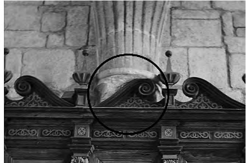
Figs. 4 e 5 - Perspectiva das abóbadas do cruzeiro e do corpo onde é visível o perfil mais rebaixado da abóbada do cruzeiro em comparação com a abóbada do corpo, bem como o prolongamento das mísulas ao longo da parede do corpo da igreja (esquerda). Pormenor das mísulas do coro alto suprimidas para a colocação de um cadeiral (direita).
