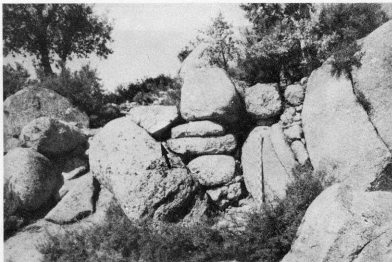
Fig. 3 — Aspecto das muralhas recentemente destruídas.
