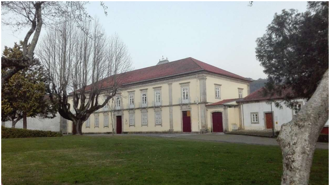
Fig. 70 Fachada principal da Casa do Terreiro, Arcos de Valdevez.
