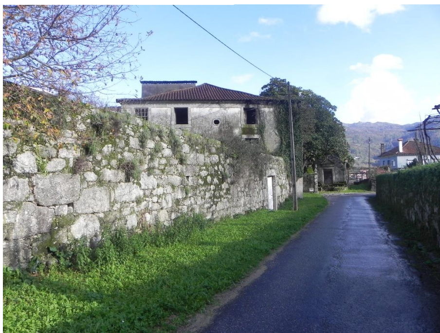
Fig. 11 Vista da fachada Sul do Solar da Agrela e estrada
