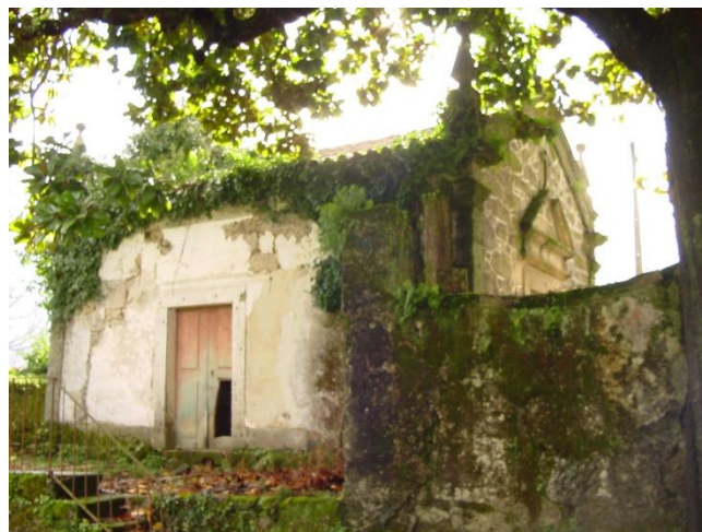
Fig. 23 Conjunto de imagens da capela e do seu interior.
