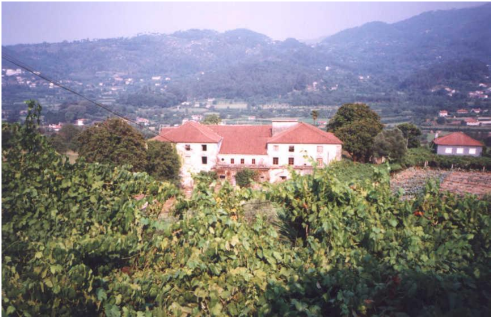
Fig. 3 Vista da fachada poente do Solar da Agrela e envolvente.
