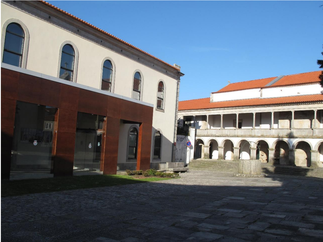
Figura 6. 1- Antigo hospital da Misericórdia de Caminha
