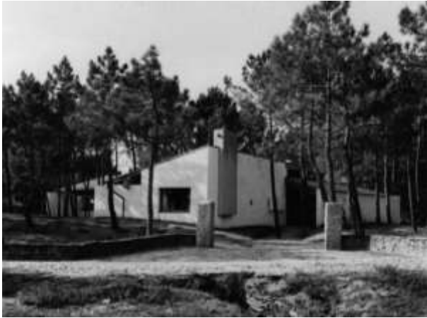
Figura 16 - Foto da casa "Dr. Ribeiro da Silva" (casa de férias em Ofir), 1956-1958, de Fernando Távora
