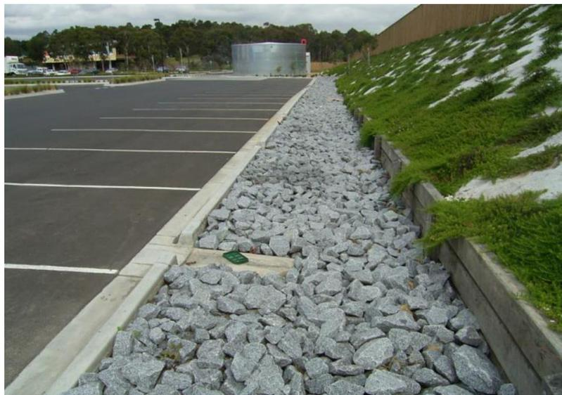
Figura 22: Trincheira de infiltração usada num parque de estacionamento, na Austrália.
