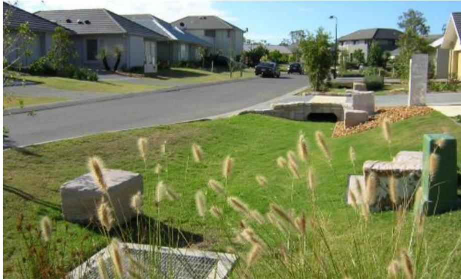
Figura 23: Vala de infiltração relevada integrada num espaço verde.
