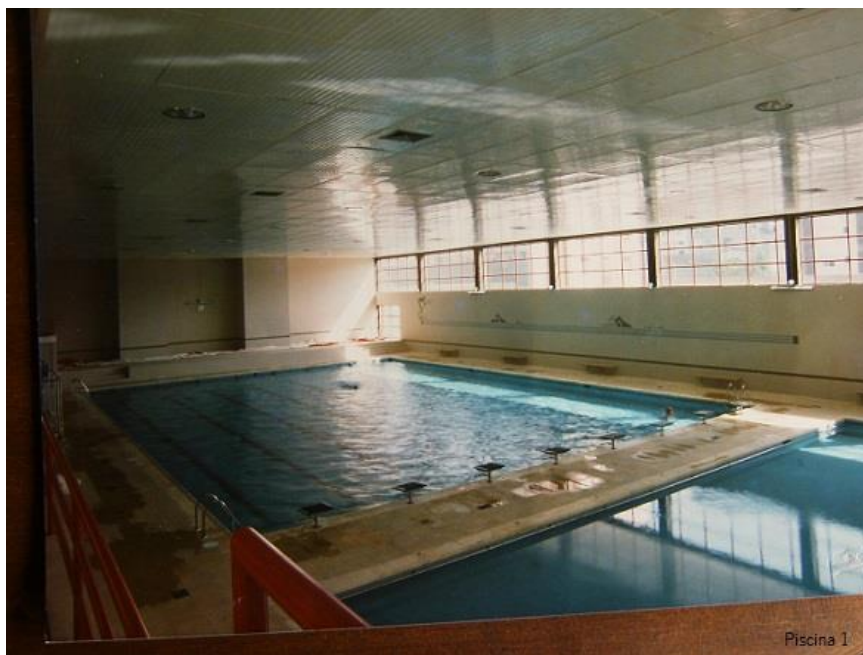
Figura 31 - Interior da piscina 1
