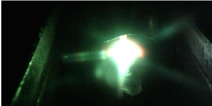
Figura 36 - Soldadura utilizando filtro de soldadura DIN 10 EN.
