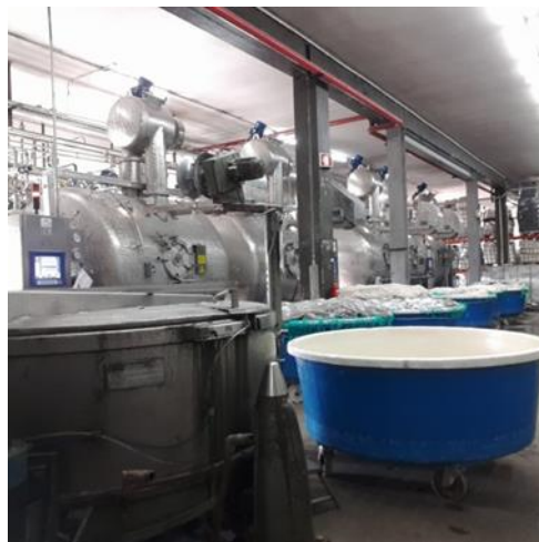
Figura 19 - Hidro na tinturaria.
