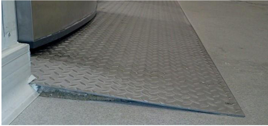
Figura 15. Rampa de saída dos túneis
