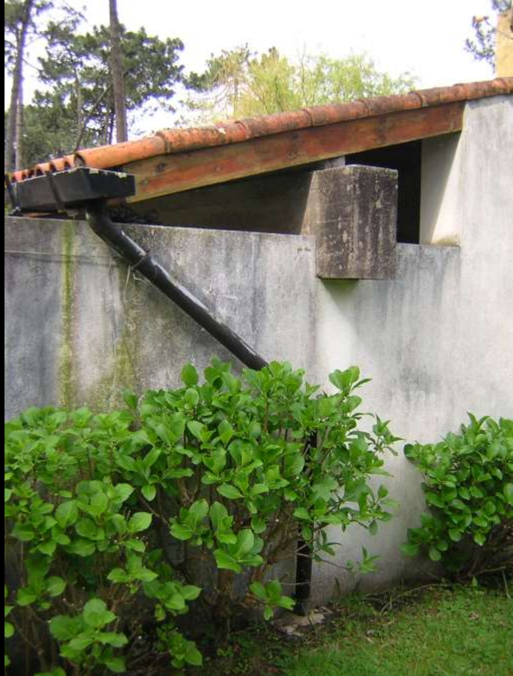
Casa de Férias – Ofir, 1957-58
