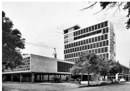
Fig. 20 – Dependência de Quelimane, fachada posterior (s.a., s.d.)
