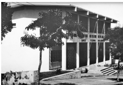
Fig. 4 – Dependência de Porto Amélia / Pemba, edifício principal (s.a., s.d.)
