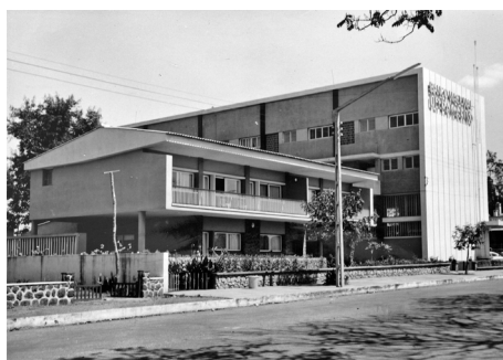
Fig. 8 – Dependência de Vila Pery / Chimoio, edifício principal e residência dos funcionários superiores (s.a., s.d.)
