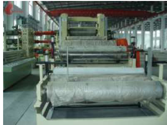
(b) Vista de uma estação de desenrolamento em instalação (reproduzido de Internal Mixers, 2016).
